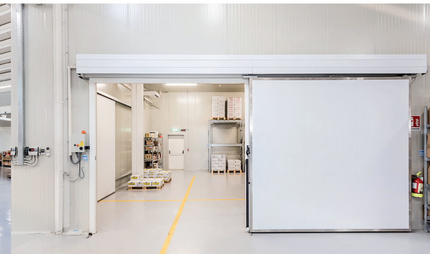
IL MAGAZZINO È DOTATO DI UN MECCANISMO DI VENTILAZIONE CHE PERMETTE DI MANTENERE LA TEMPERATURA DELL'ARIA COSTANTE A 25°C
